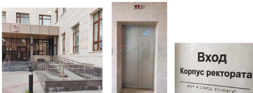
Рисунок 2. Пандус у блока 3 нового корпуса. Лифт нового корпуса. Вывески с названием организации в новом корпусе мне найти не удалось
