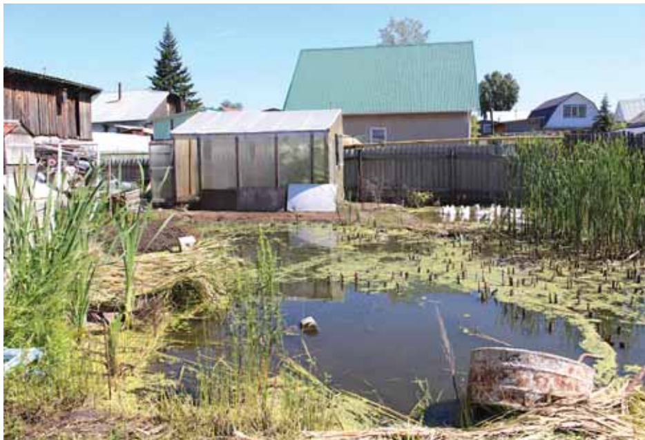
Частные дома на ул. Октябрьской в Бердске разрушаются из-за подтоплений.
